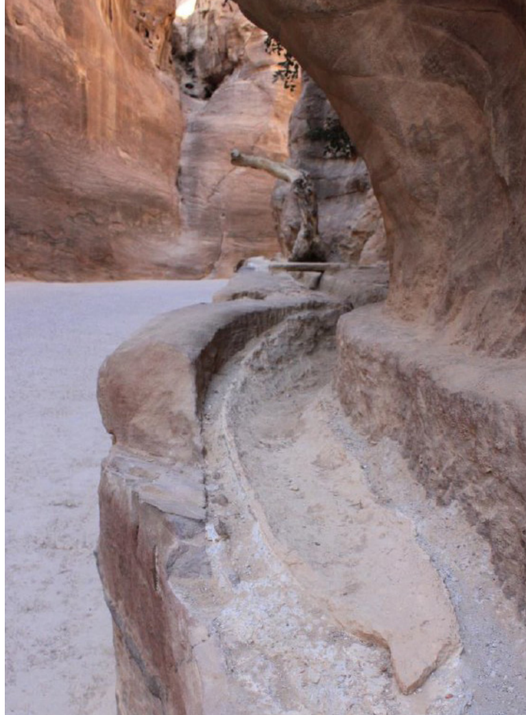
● ペトラ中心部まで水道管を通した跡
